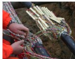
Настављање подземног телекомуникационог кабла
